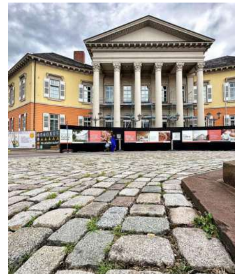
Beim Markgräflichen Palais laufen die Rückbauarbeiten. Foto: Rake Hora
